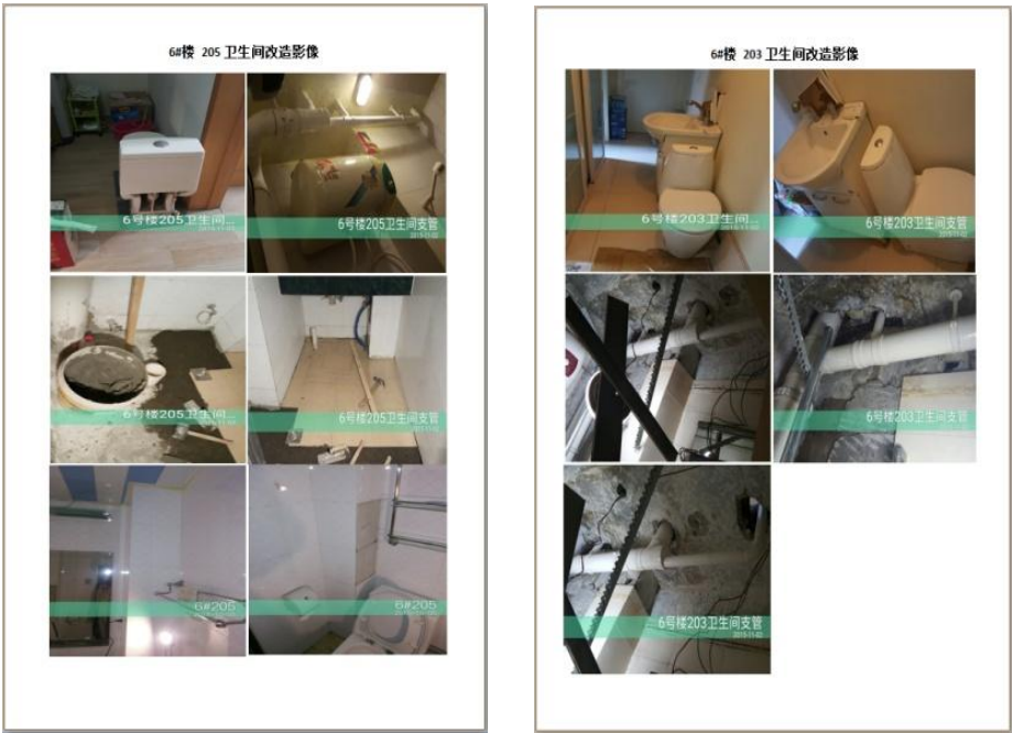
图 35 每户施工进行影像留存
