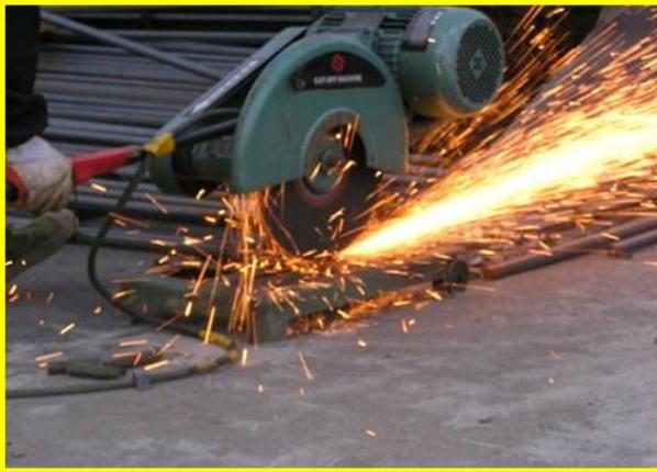
钢筋端头采用砂轮锯切除
