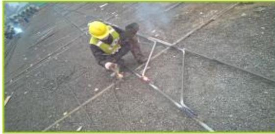
钢筋骨架片在空场地连接
