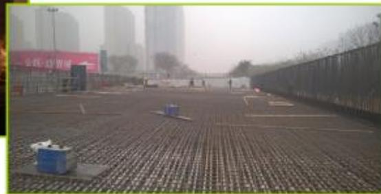
安装完成的顶板钢筋
