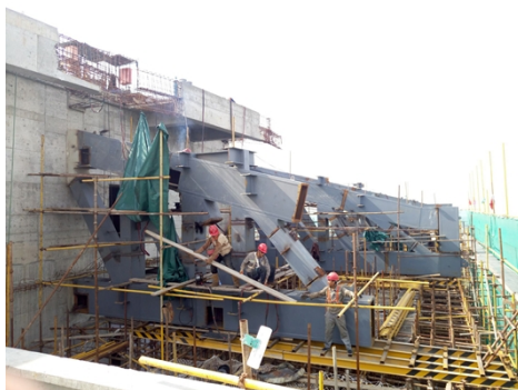
图9钢桁架现场安装示意图
