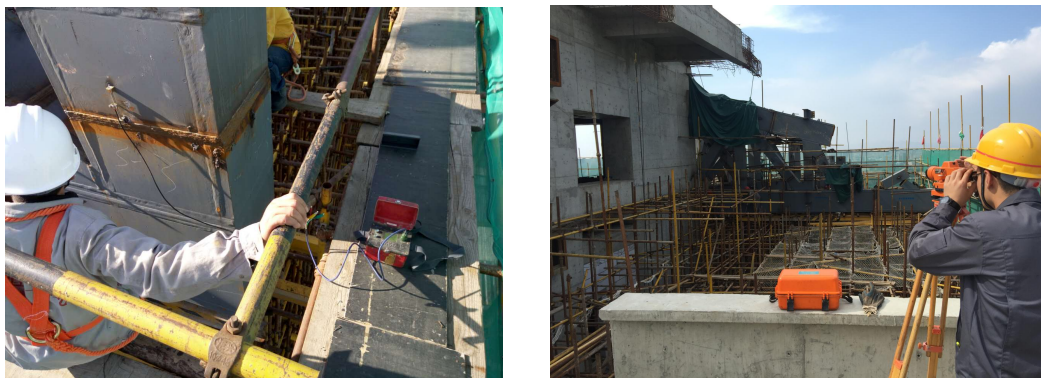
图14钢桁架安装过程现场检测
