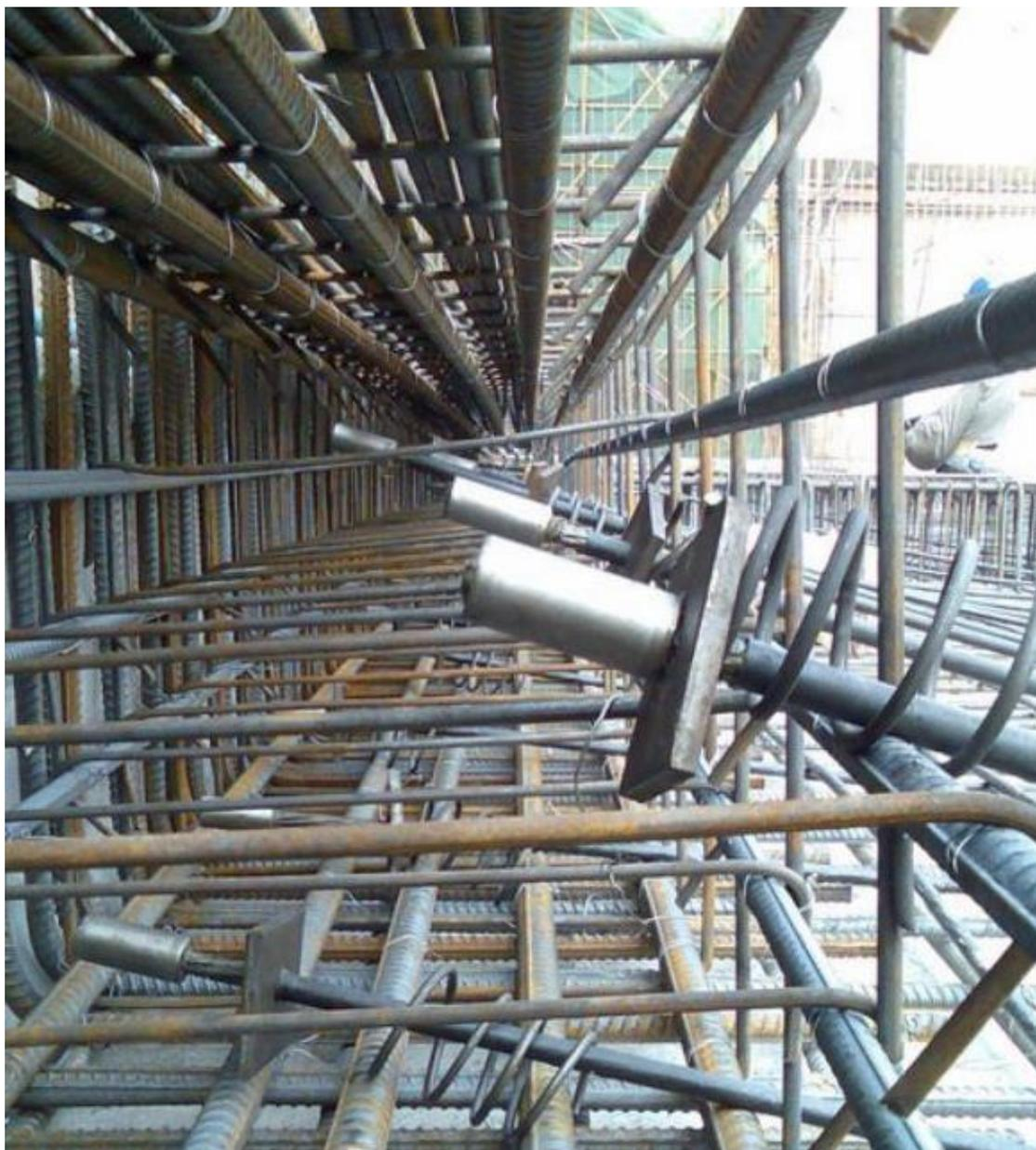
预应力筋锚固端内部景
