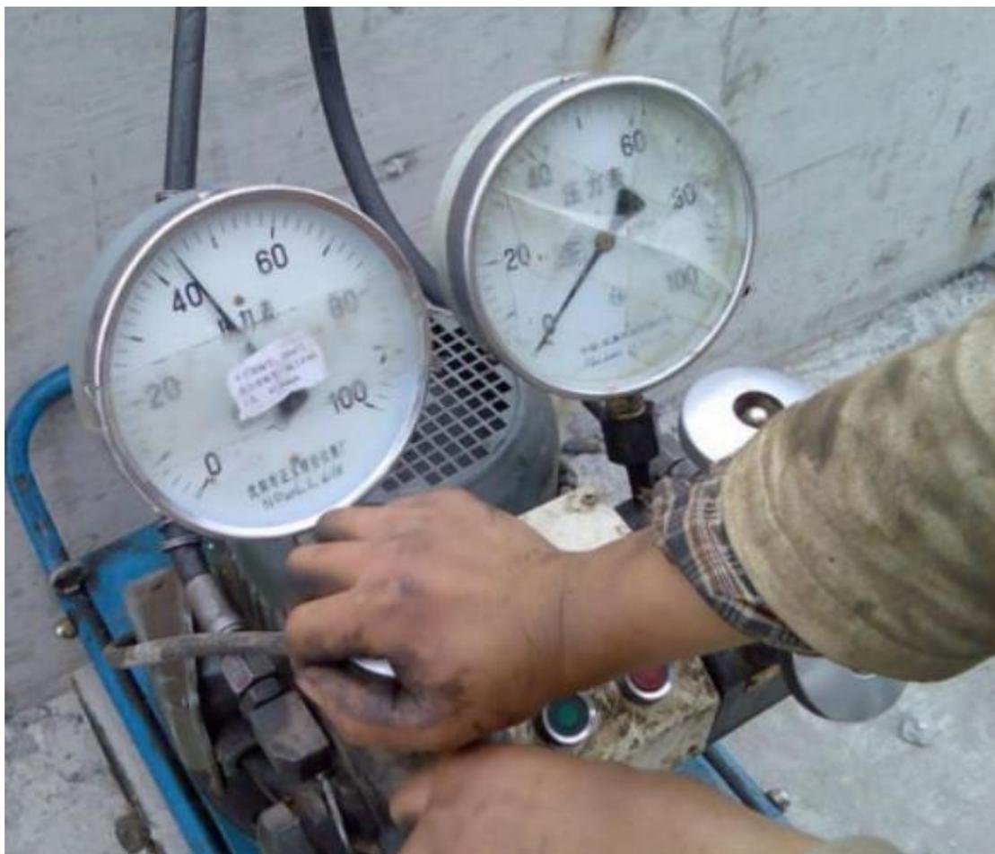
张拉到设计值，注意压力表的变化，此时压力表正好为 43.94mpa
